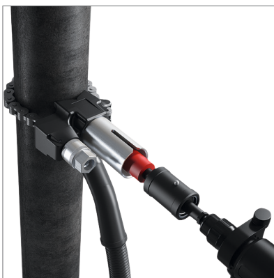
Abb. 18: Die Bohrung mit einer handelsüblichen Bohrmaschine ausführen. Die Stahlspäne können dabei über den Staubsaugerstutzen abgesaugt werden. Danach die Bohrvorrichtung wieder abnehmen.
